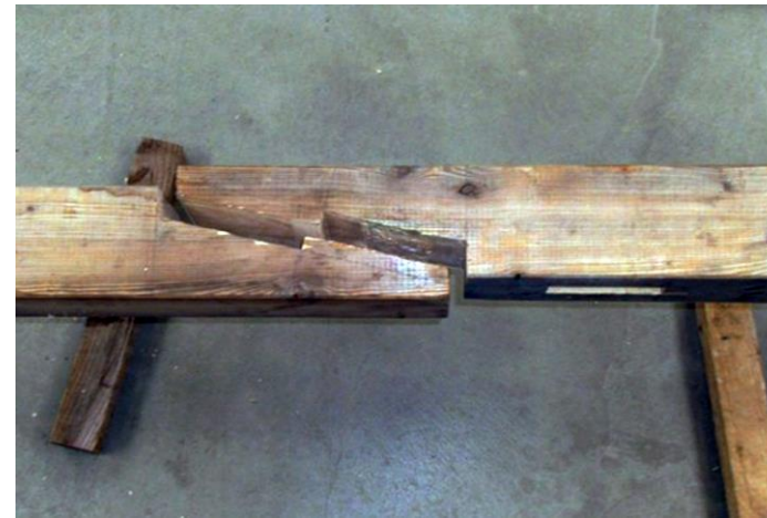
Firstpfette mit schrägem Hakenblatt
