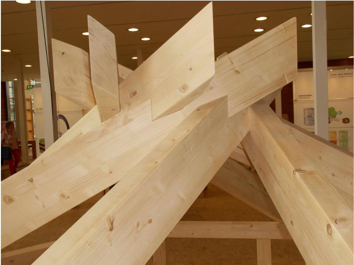
Firstpunkt des Mandala-Daches
