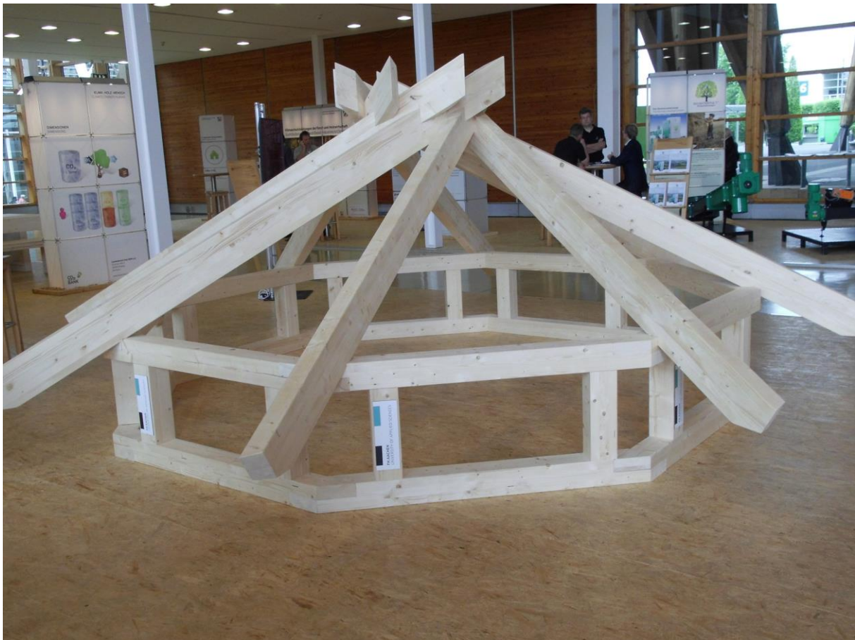
Mandala-Dach, freitragende Dachkonstruktion ohne mittlere Stütze
