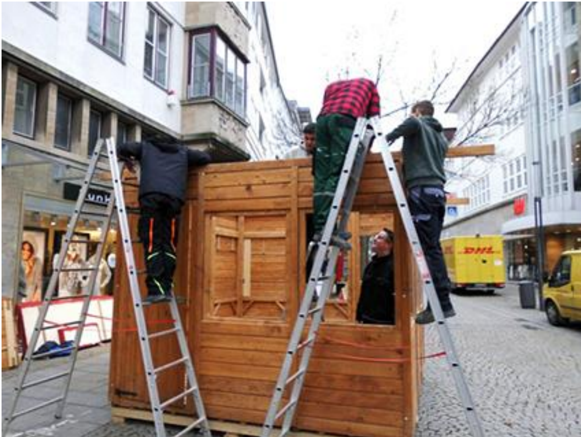
3. Die Fußpfetten werden angebracht
