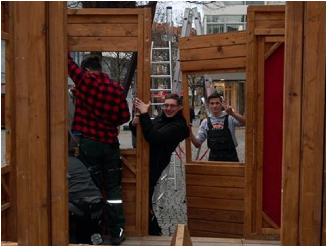
2. Die vierte Wand wird gerade geschlossen
