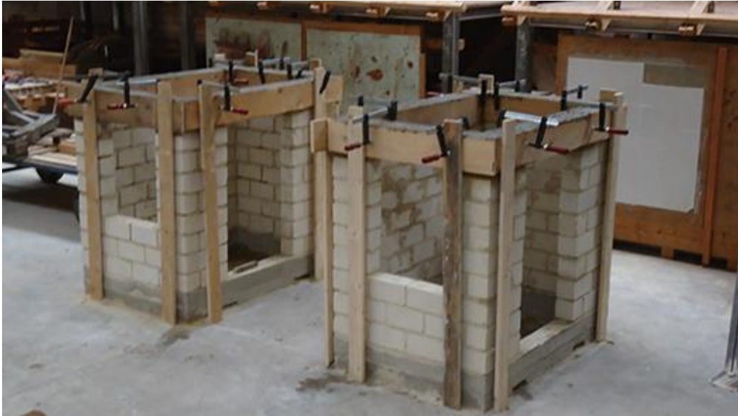
Die Wände stehen, der Ringanker wird betoniert.
