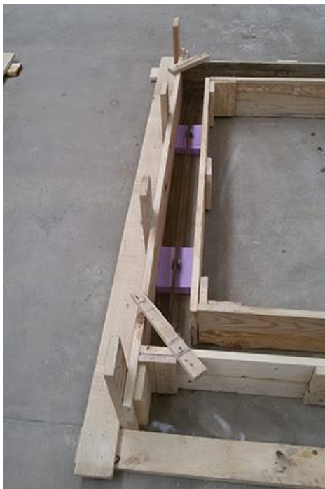
Fundamentalschalung mit Stahleinlage
