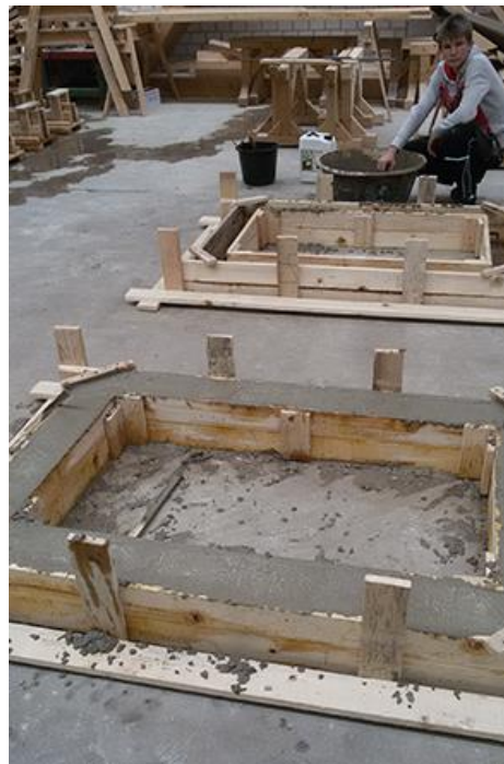
Fundamente werden betoniert.
