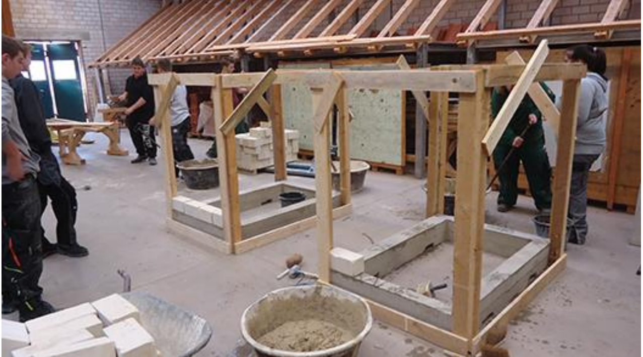
Fundamente mit Mauergerüst
