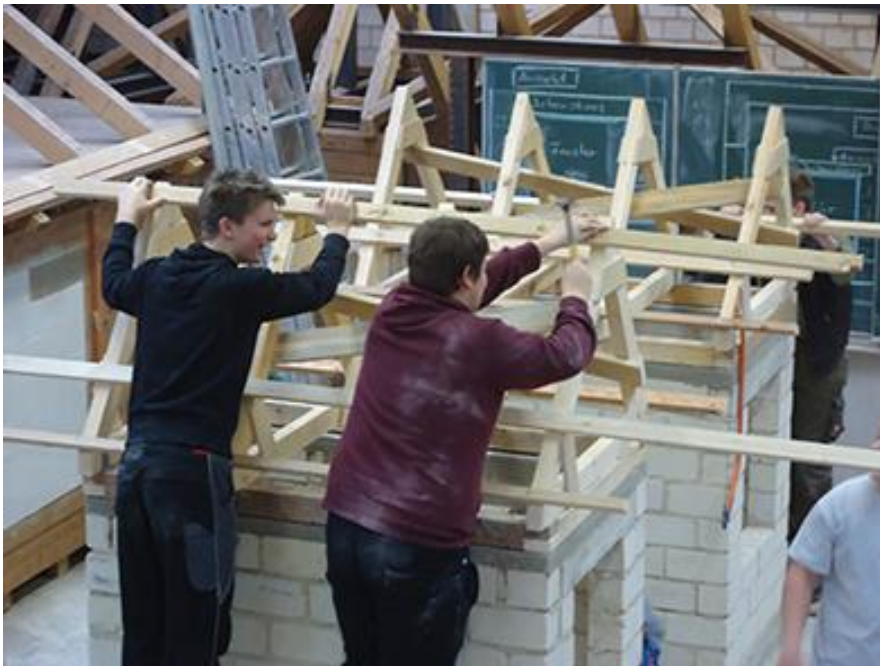
Der Windverband ist eingebaut, es wird eingelattet!
